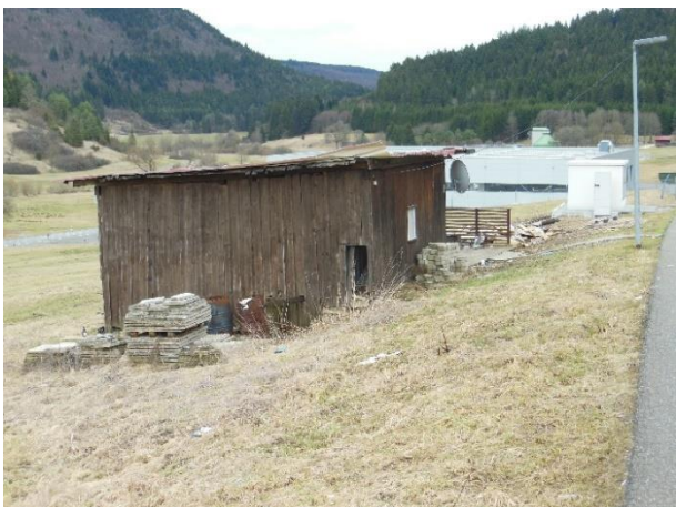
Foto 5: Improvisiertes Gebäude um einen Bauwagen herum errichtet (Freizeittreff „Bauwagen Egesheim 2“) im Südosten des Plangebiets liegend.
